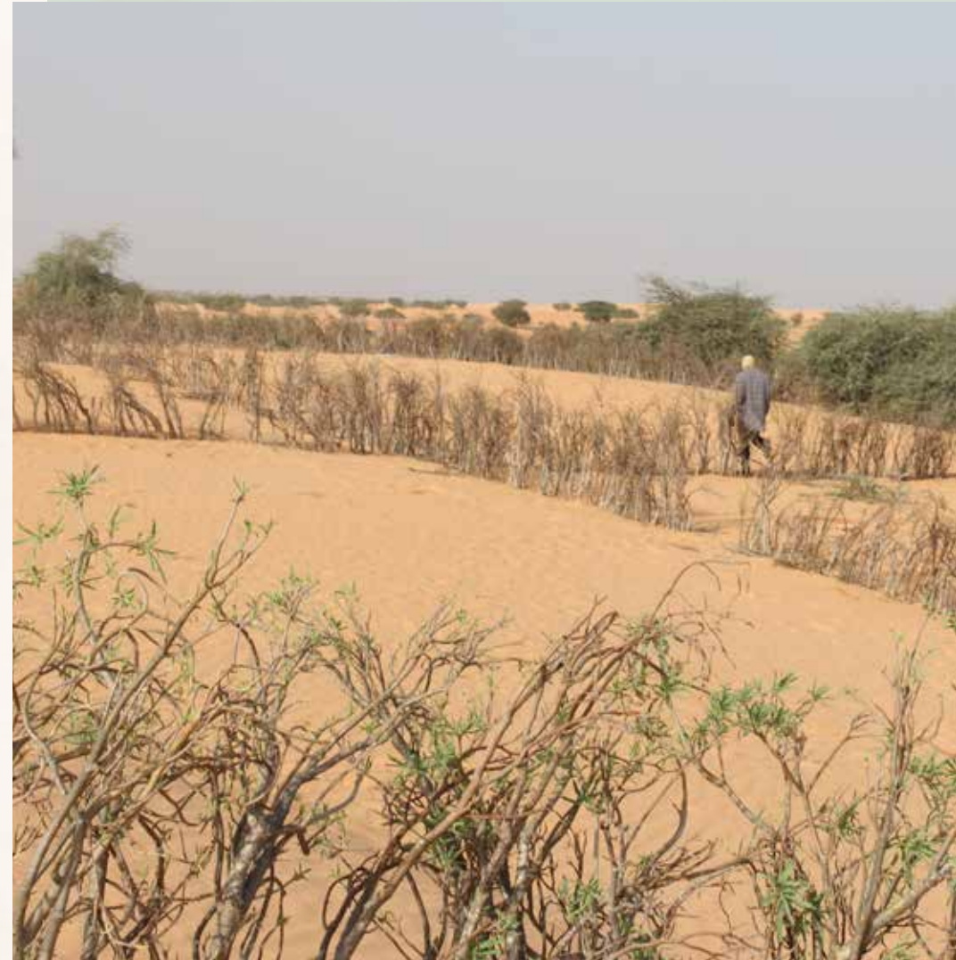
Travaux de protection contre l'ensablement par des bois autochtones, Mauritanie
