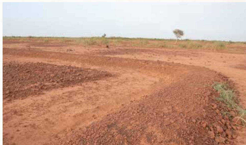
Technique des banquettes anti-érosives, Karey Gorou, Niger
