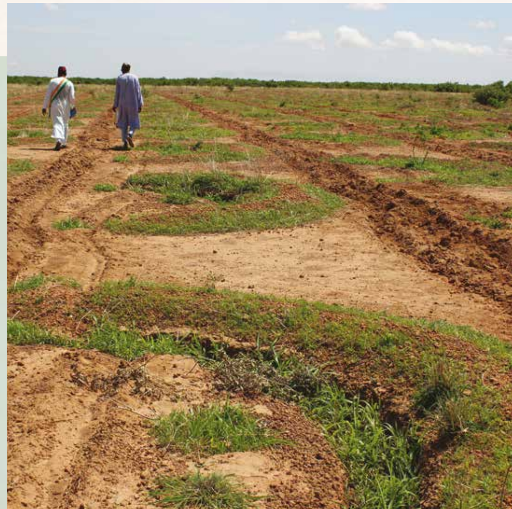
Ouvrages de demi lunes pour lutter contre la désertification, récupérer les terres désertiques et préserver les cultures, Niger
